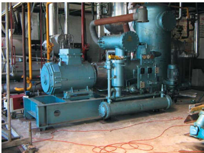
Sprężarka śrubowa firmy HOWDEN w trakcie montażu
