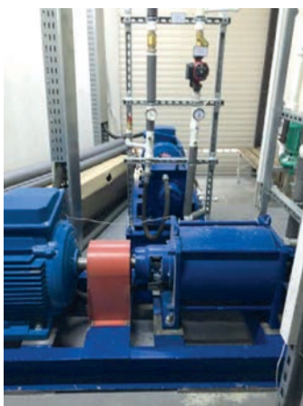
Fot. 1. Jednostka grzewcza oparta na dwóch generatorach typu NGT-075
