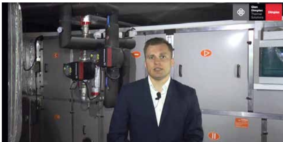
Rys. 3. Widok centrali wentylacyjnej (z odzyskiem ciepła), gdzie ogrzewane powietrze wentylacyjne jest z gruntowej pompy ciepła SI 50TU marki Dimplex (lewa strona z pompą obiegową) oraz wstępnie ogrzewane zimą lub chłodzona latem dolnym źródłem ciepła (pasywnie) – (prawa strona z pompą obiegową) (źródło: zrzut ekranu z filmu „Dimplex – praca w kaskadzie nie zawsze się opłaca” z kanału YOUTUBE Glen Dimplex Polska)
