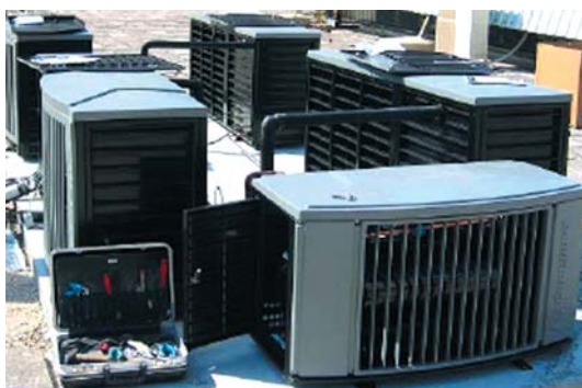
Rys. 6 Montaż sieci czterech agregatów skraplających Copeland EazyCool™ w Splicie w Chorwacji
